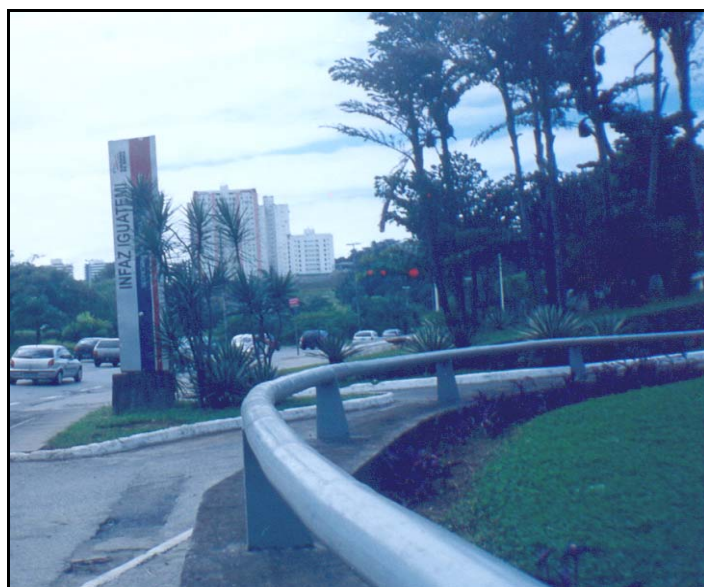
Figura 11. Vista do canteiro da Avenida Juracy Magalhães
