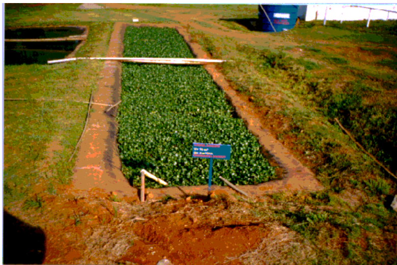
Figura 10 - Lagoa de aguapés para tratamento de chorume
