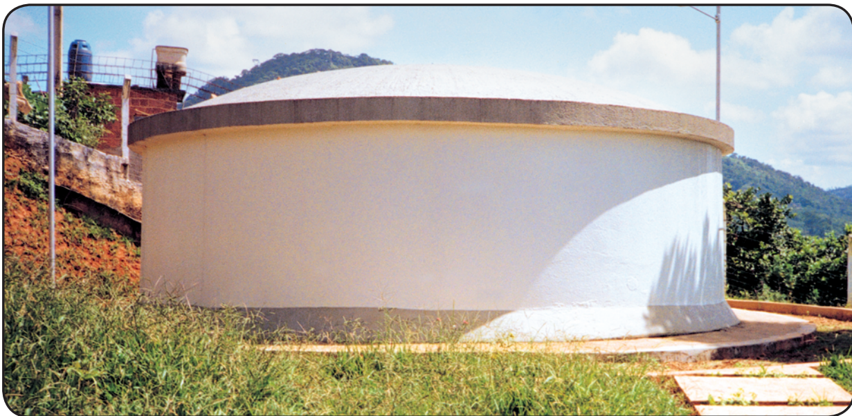
Foto 5 – Reservatório em concreto armado apoiado
