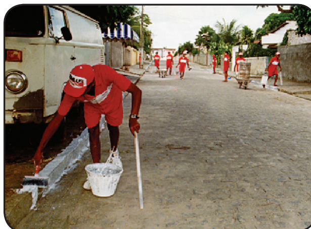
Foto 18 – Pintura de meio-fio
