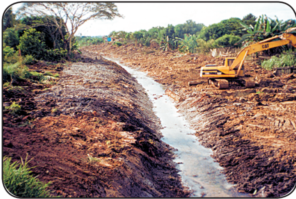
Foto 29 – Retificação de Canal Natural
