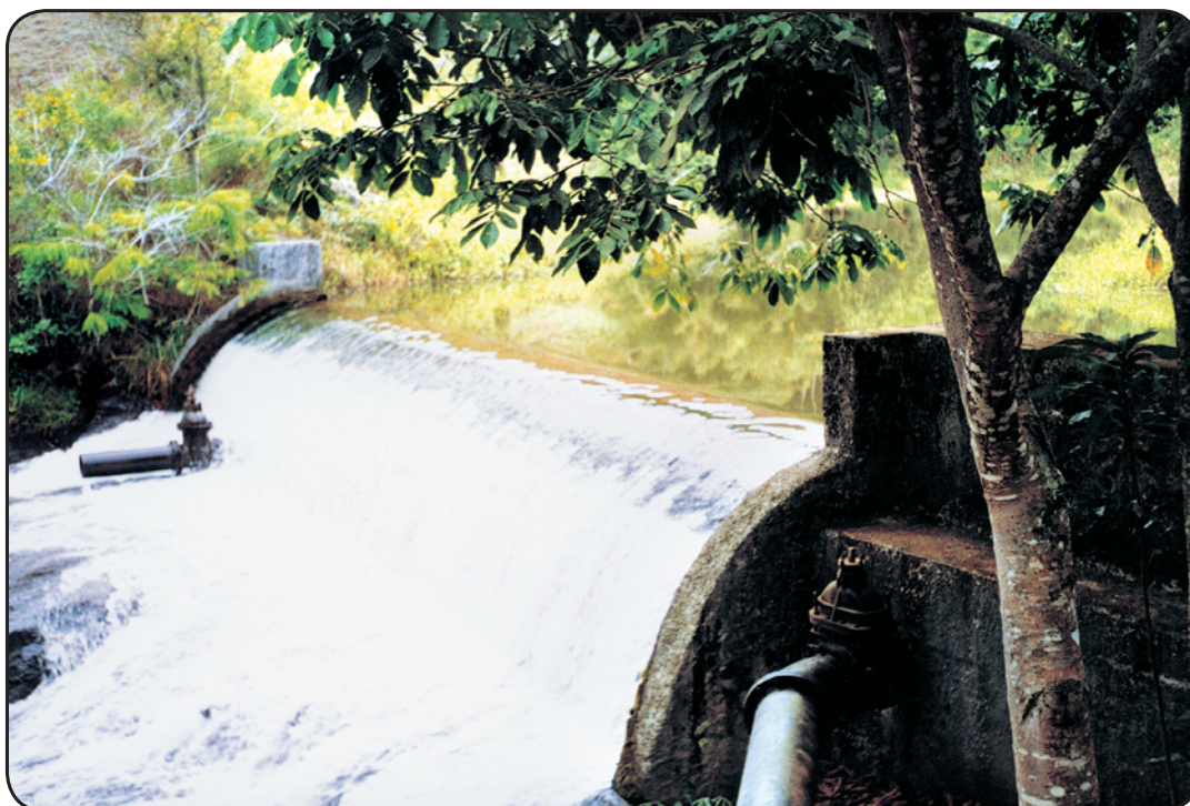
Foto 1 - Tomada direta com barragem de nível
