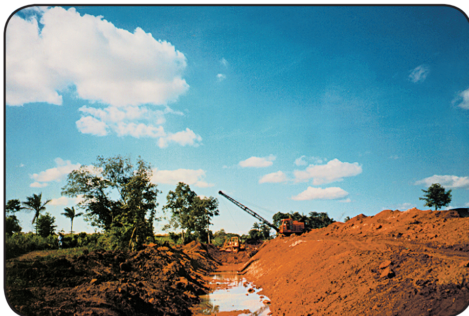
Foto 31 – Dragagem com drag-line
