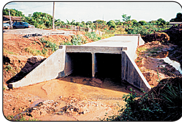
Foto 30 – Galeria de Concreto Armado
