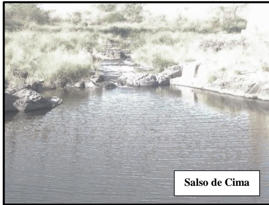
Figura 09: Arroio Saldo de Cima – SC 8.
