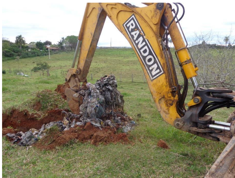
Figura 3. Constatação da disposição irregular de resíduos sólidos.
