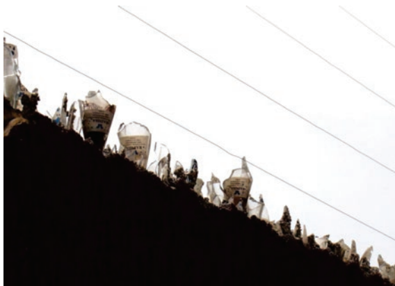
Figura 11. Muro com fragmentos de vidro instalados e cerca elétrica para repelir pombos.
